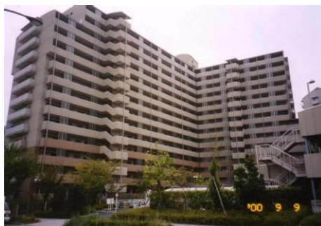
西神 MANSION 營造:飛島建設 集合住宅 1995.6完工,地震時結構體完成 距震源10公里以內
