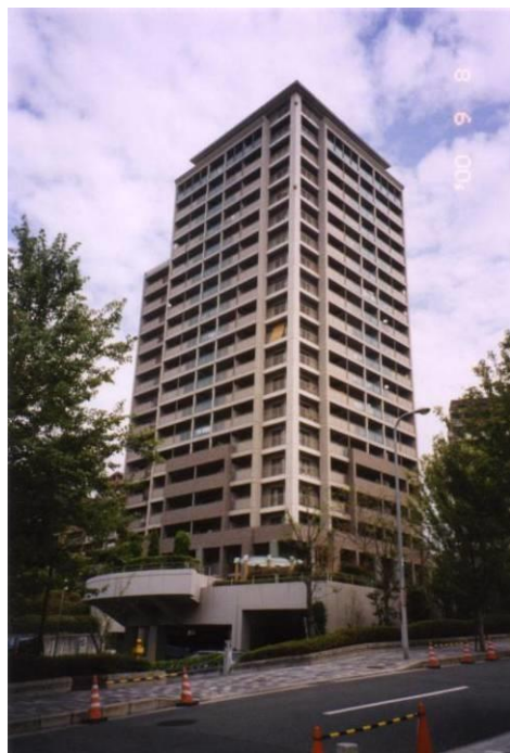
阪急土室BILUZUCOTO第二期 營造:大林組 20層集合住宅 1993.7地震前完工 距震源50公里以內
