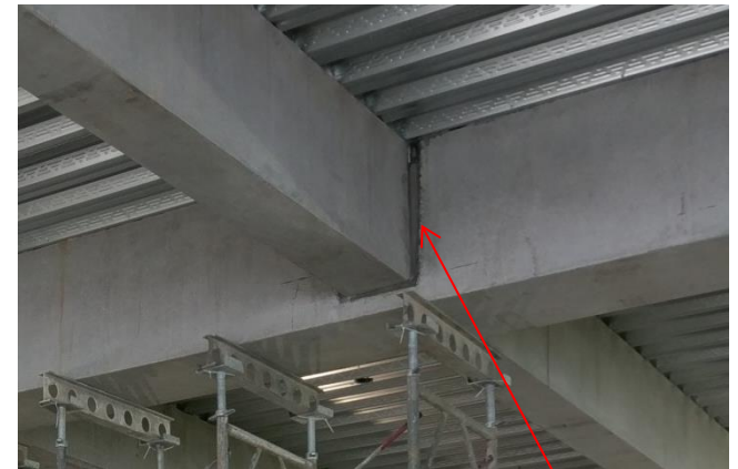
結構砂漿填塞
