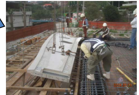
樑柱接頭箍筋
