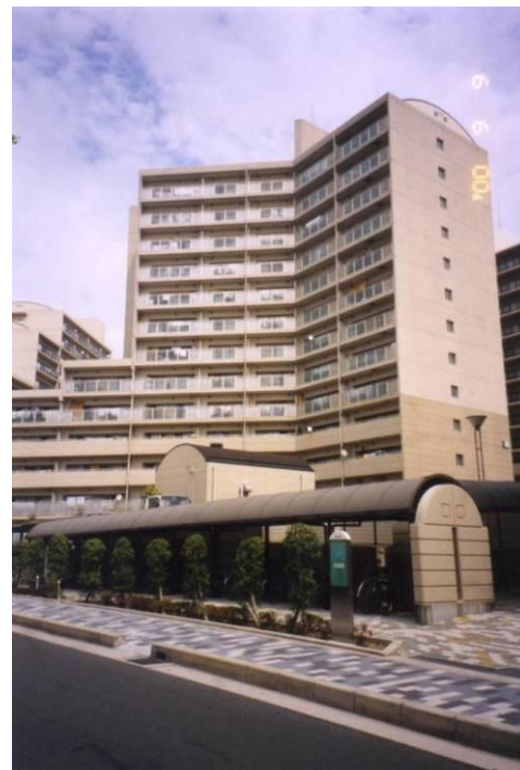
府營豐中服部本町高層住宅 營造:FUJITA 集合住宅 1995.7完工,地震時結構體 已完成距震源30公里以內
