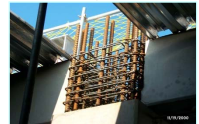
樑柱接頭箍筋
