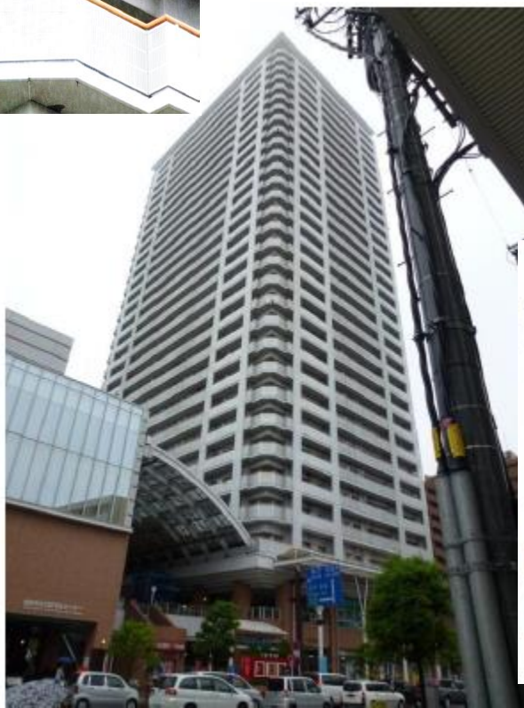
Nagamachi Lions Tower in Sendai, 29F,3F以下現澆，構架系統， 地震時僅陽臺版局部混凝土掉落
