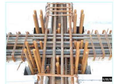
上層鋼筋鋪設
