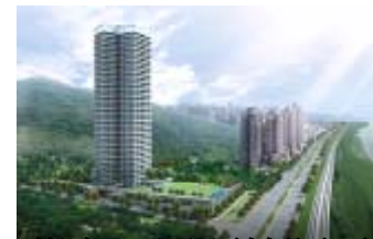
藍海38層預鑄隔震大樓
